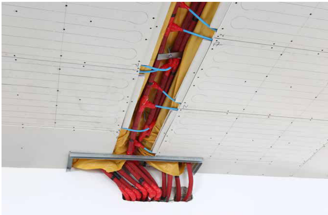
Рис. 6. Система потолочного охлаждения с использованием греющих-охлаждающих панелей системы KAN-therm Wall.
