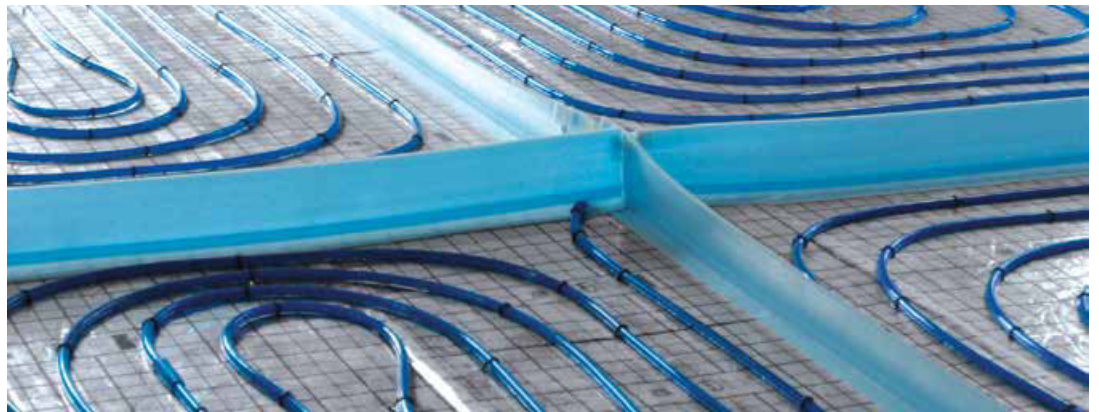
Рис. 14. Деление греющей поверхности разделительными швами.
