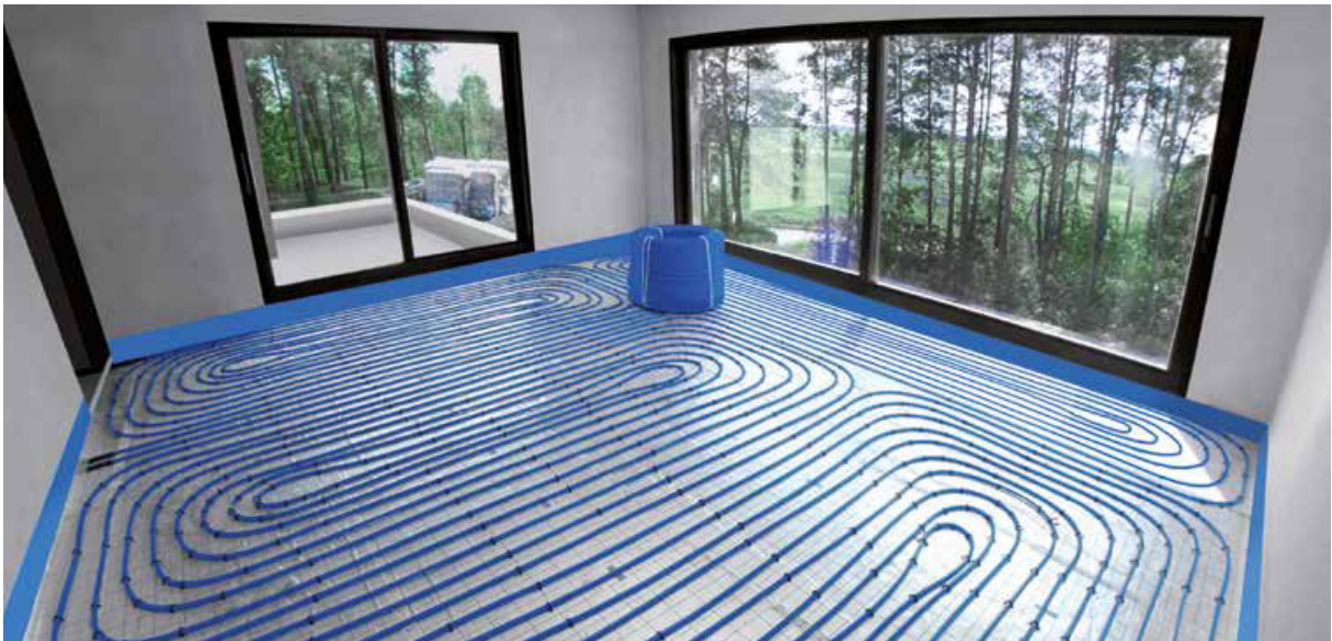
Рис. 3. Система напольного отопления в частном доме при использовании труб bluePERT и системы крепления труб KAN-therm Tacker.
