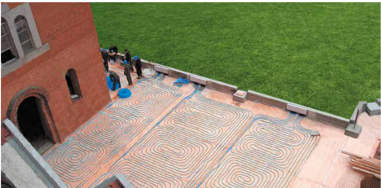
Рис. 5. Система подогрева открытых наружных поверхностей при использовании труб bluePERT системы KAN-therm.
