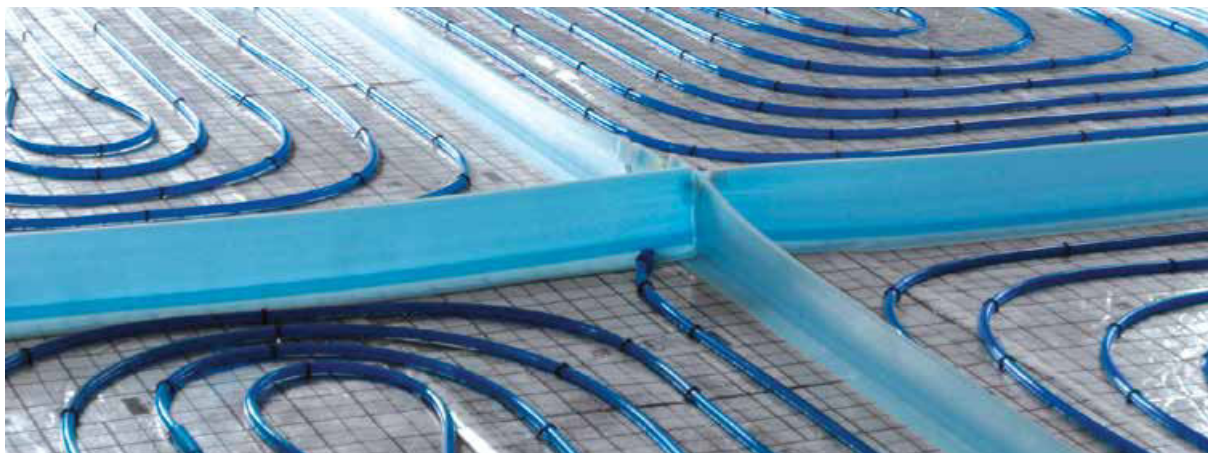
Рис. 14. Деление греющей поверхности разделительными швами.
