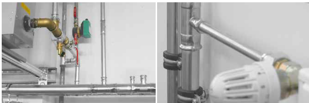
Примеры монтажа оборудования KAN-therm Steel
