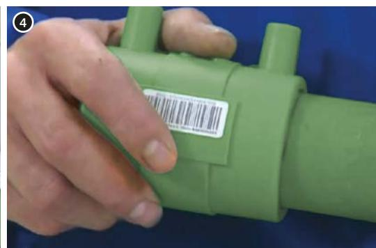
5. Программирование электромуфтового сварочного аппарата через сканер штрих-кода (электромуфтовый сварочный аппарат автоматически корректирует параметры сварки).
