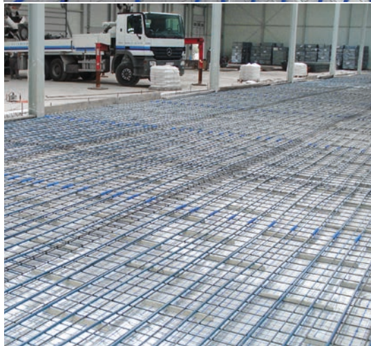
Рис. 4. Система панельного отопления в складском помещении при использовании труб PE-RT Blue Floor и системы KAN-therm NET.
